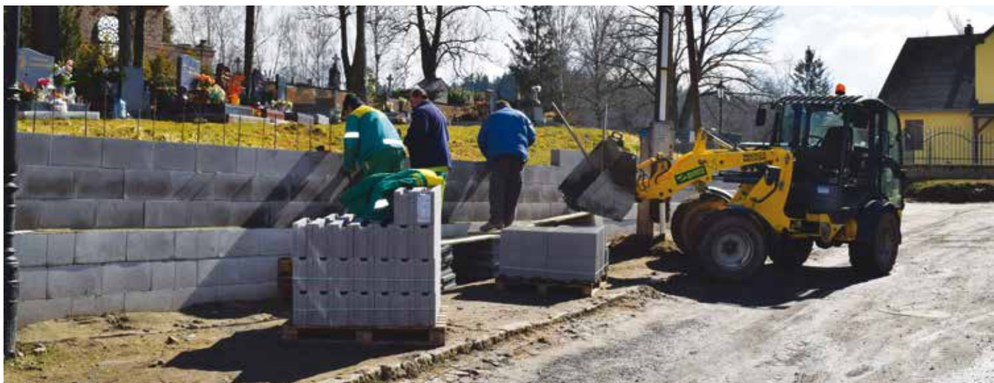
Stavba hřbitovní zdi 18. března, foto Jan Staněk
