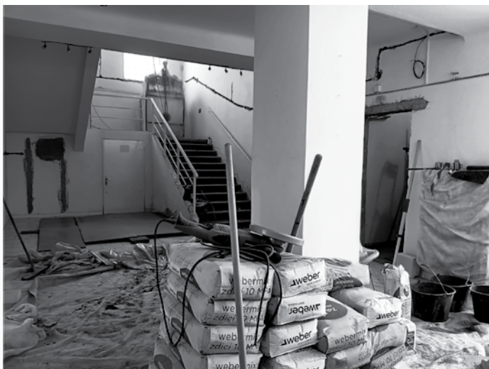
Stavební práce v městském muzeu jsou v plném proudu, foto Hana Staňková
