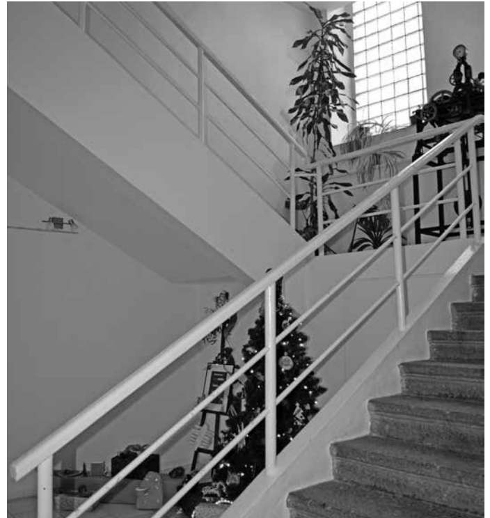
Schodiště v Městském muzeu, do kterého je plánována vestavba výtahu, foto Hana Staňková
